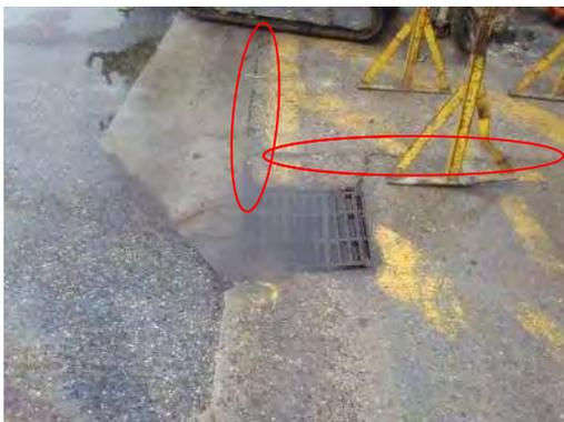
Photographie 3 : Vue sur une fracture de la dalle béton au droit de l'aire de dépotage et d'un débordement du réseau d'eaux pluviales
