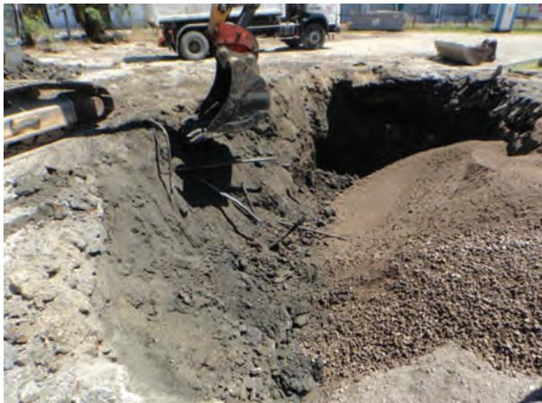
*Remblaiement de la fouille au droit des pistes de distribution avec des matériaux propres*
