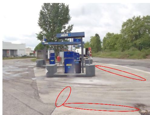
Photographie 4 : Vue sur des fissurations de la dalle béton au droit des pistes de distribution
