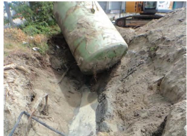
*Extraction du réservoir enterré de 20 m<sup>3</sup> GO (R2)*
