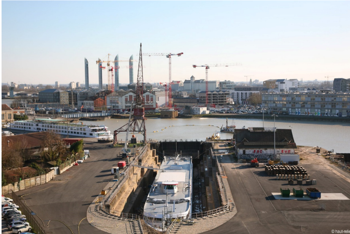
Forme de radoub # 1- Bordeaux
