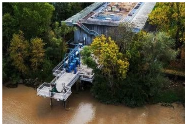
Figure 38: Usine de production d'eau industrielle (Presqu'île d'Ambès). Source : https://leaubordeauxmetropole.fr/
