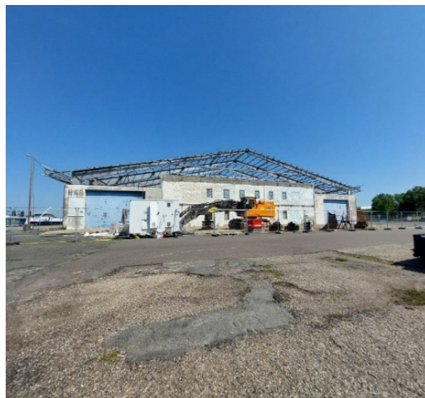
Figure 16: Déconstruction du hangar 45 à Bassens
