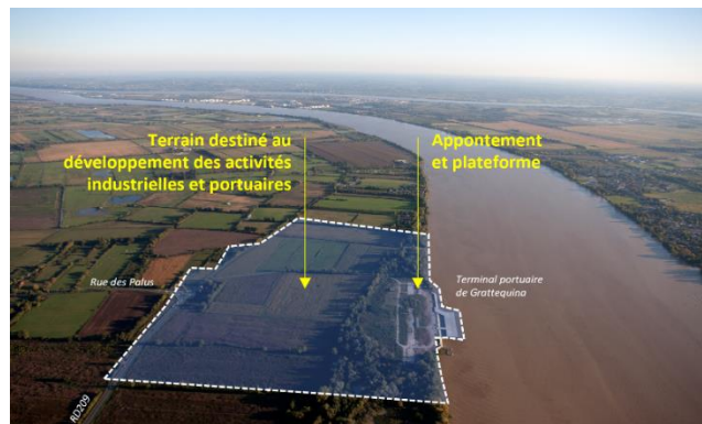
Vue actuelle du terminal Grattequina
